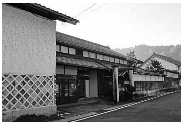
起業・創業支援施設「古民家オフィス みらいと奥出雲」
