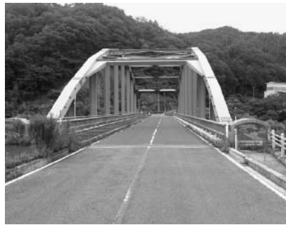
▲塗装塗り替え工事を行う「たたら大橋」
