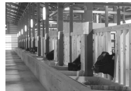
▲改修した旧横田肥育センターの繁殖施設
