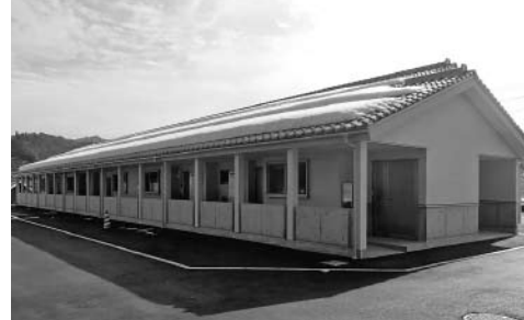
▲建て替え工事が完了した町営土橋住宅
