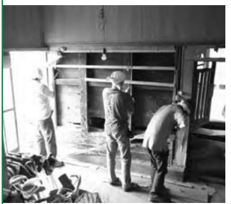
▲空き家の改修を体験
