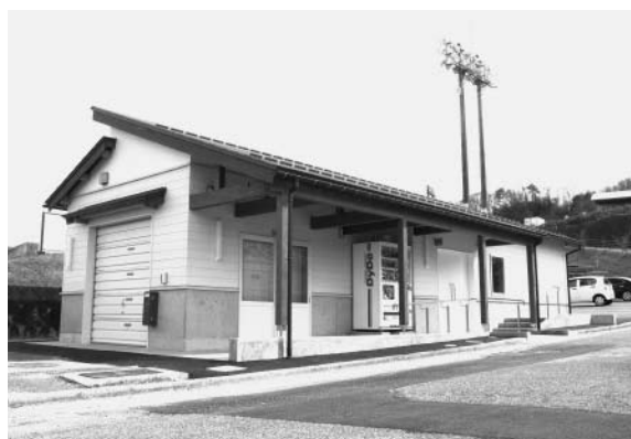
▲改修された三成公園野球場管理棟
