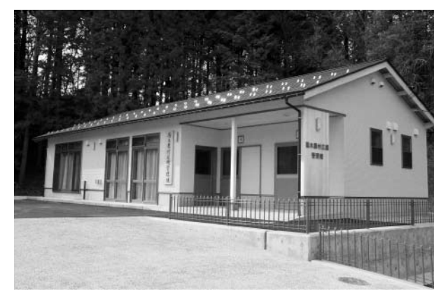
▲完成した馬木農村広場管理棟
