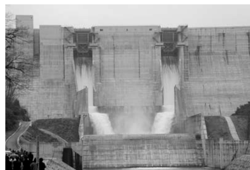
勢いよく放流する尾原ダム
