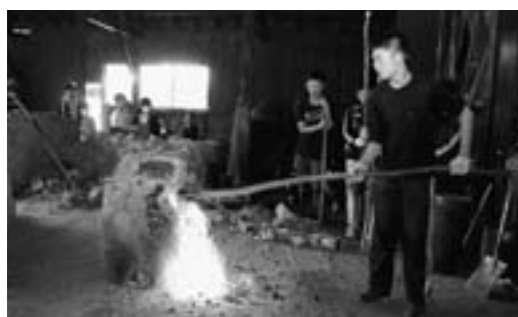
▲慎重に炉を解体する様子
