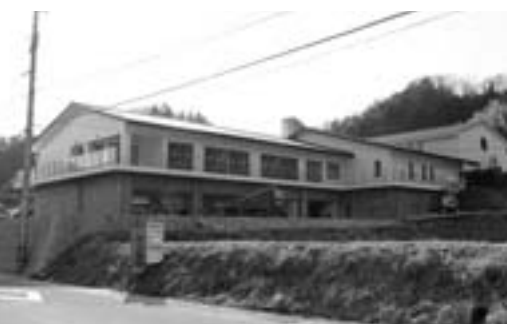
▲20床増床される「あいサンホーム」
