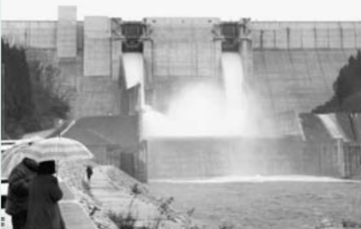
▲非常用水門から放流が行われた尾原ダム
