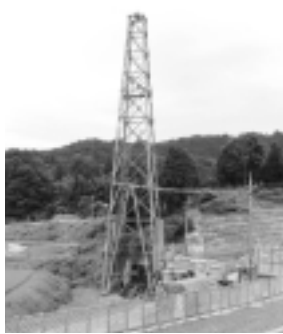
佐白地区交流拠点施設のボーリング工事
