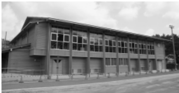
体育館が完成した亀嵩小学校
