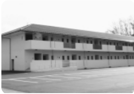
完成した滝の上第1団地2号棟
