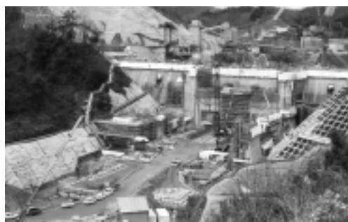
工事が着手と進む尾原ダム(ダム本体下流部から)
