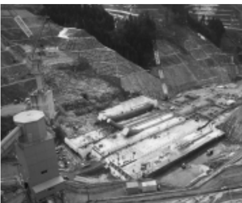
着々と工事が進む尾原ダム建設現場
