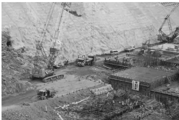
▲コンクリート打設が始まった工事現場
