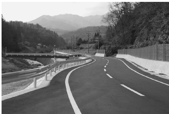
▶ 完成した上市工区
