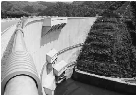
▲ 堤の高さ156メートルを誇る温井ダム
