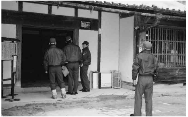
▲ 点検を行う消防署員（糸原家）
