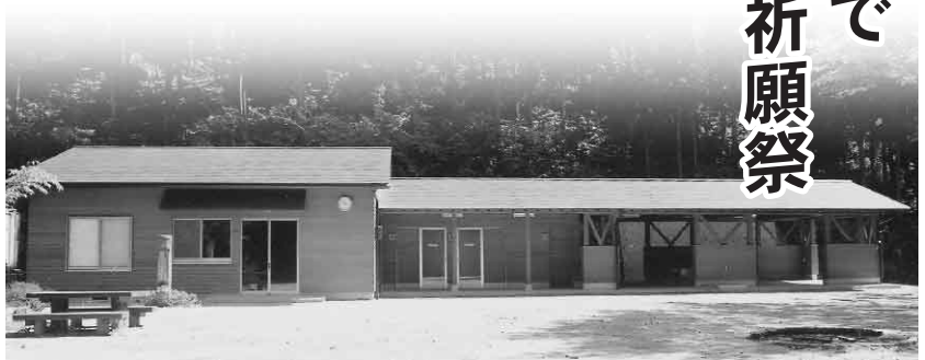
▲ 竣工した玉峰山森林公園内の諸施設
