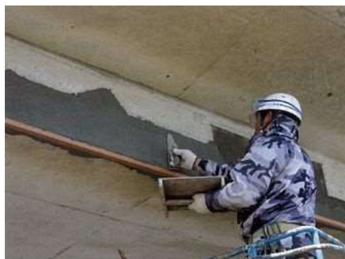
写真4-3 断面修復状況
