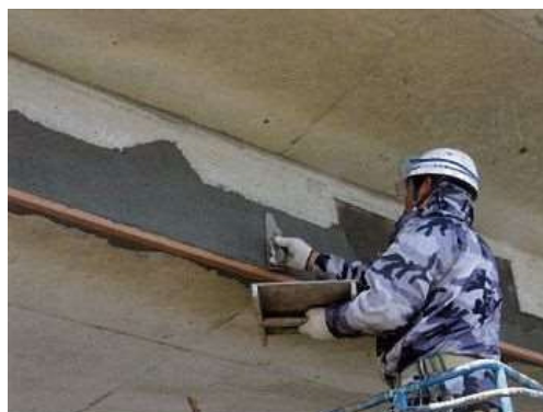
写真4-3 断面修復状況
