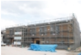
改築が進む馬木小学校屋内運動場
