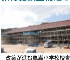
改築が進む亀嵩小学校校舎
