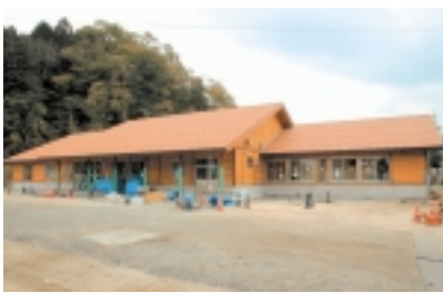
完成間近の八川幼稚園
